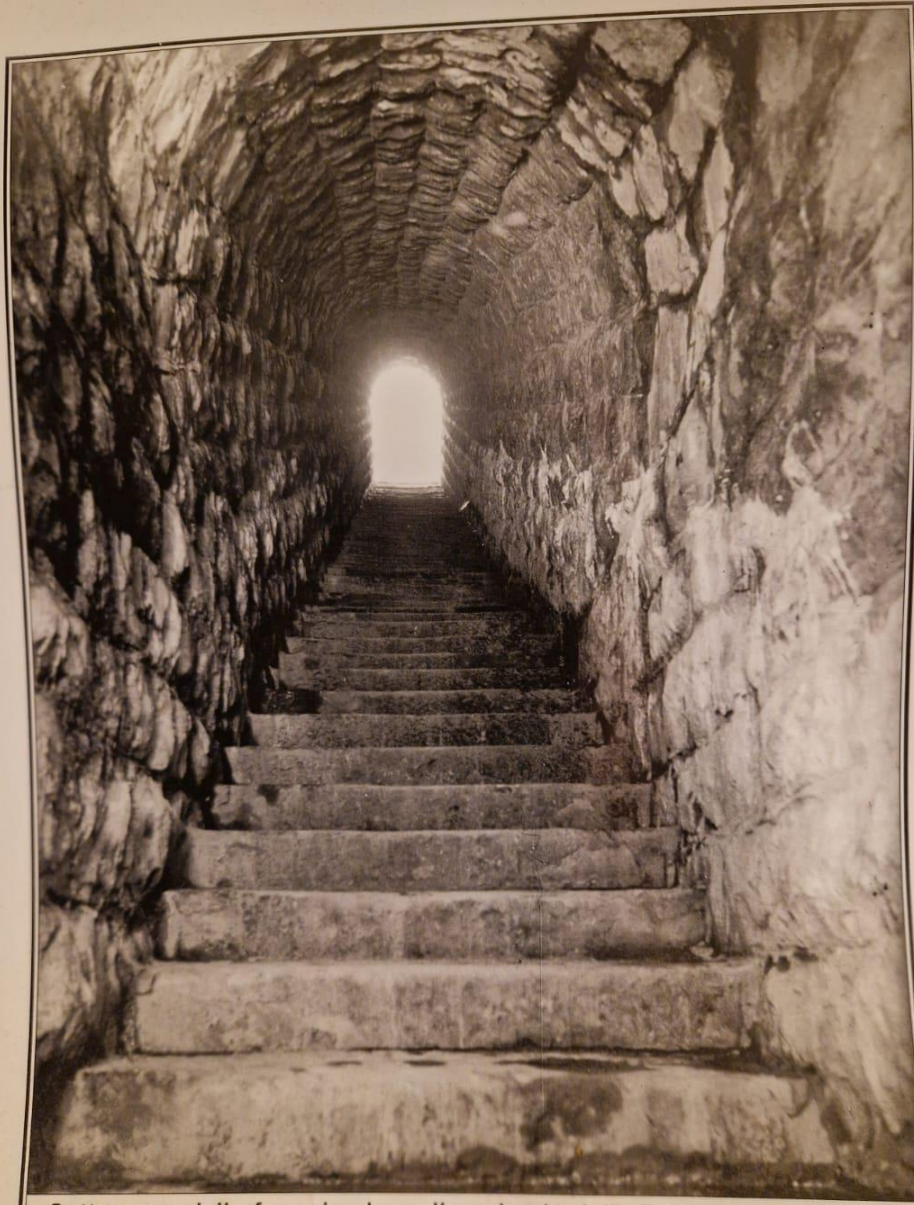
Sottopasso della ferrovia che collega la via della Tesa a via del Veltro. Venne utilizzato come ricovero pubblico antiaereo per 62 persone.
