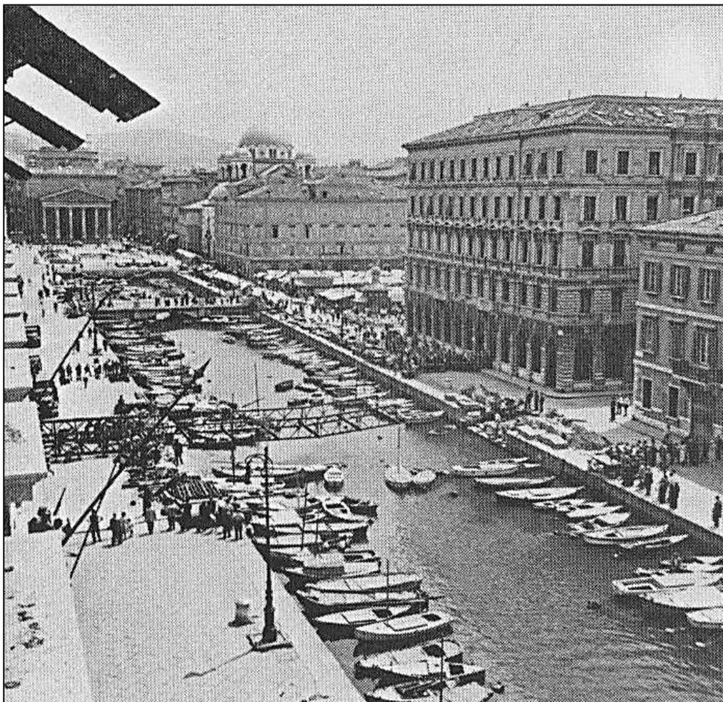
Nel 1950 i ponti Bianco e Verde all'inizio del canale erano usurati dal tempo. Venne prevista la loro rimozione e la realizzazione di un unico ponte fisso in cemento armato, ritenuto più solido e funzionale.
