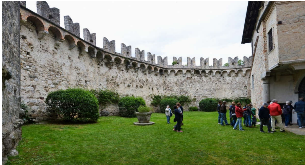
Cortile posteriore con la torre
