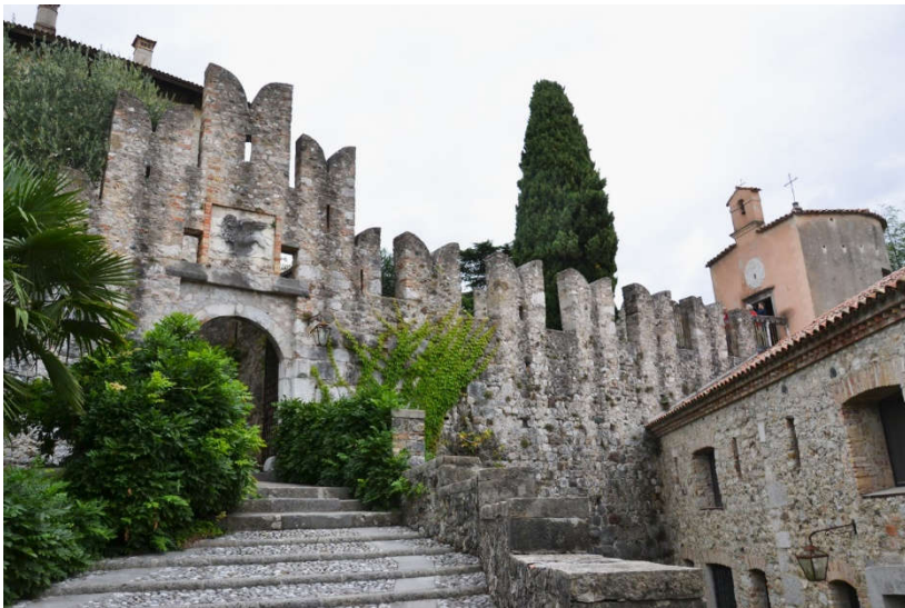
Porta di accesso al cortile superiore con merlatura
